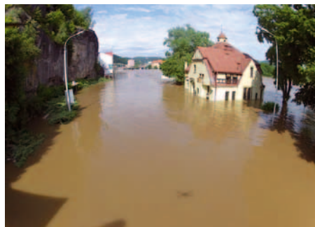
Zatopená budova restaurace U Přístavu na levobřežní části Děčína
