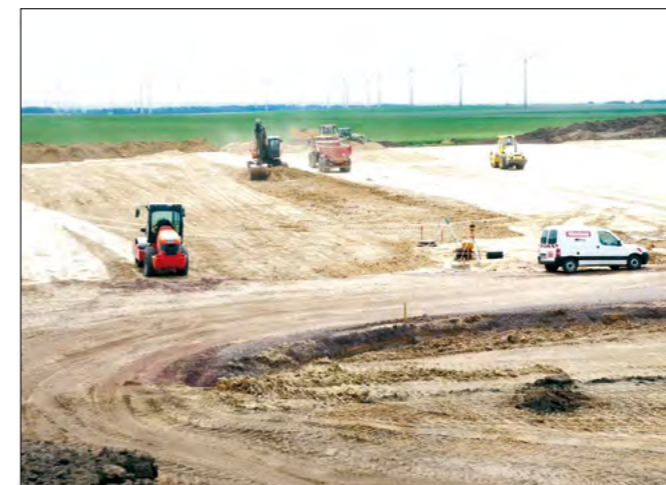
Stavba biometanové teplárny bude dokončena v létě 2012.
