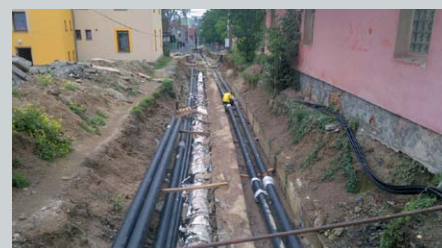
Více než 3,5 km starých trubek bude vyměněno za moderní předizolované.
