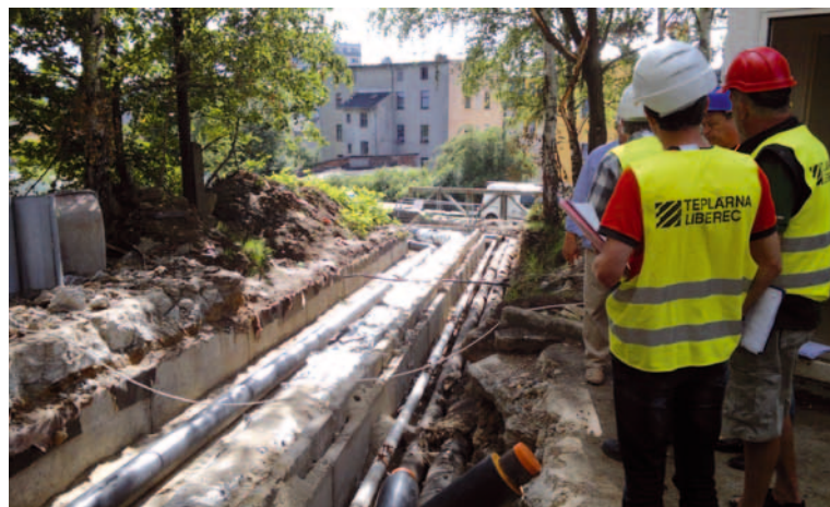
Na sídlišti bylo uloženo 3,5 km nových moderních předizolovaných horkovodních trubek
