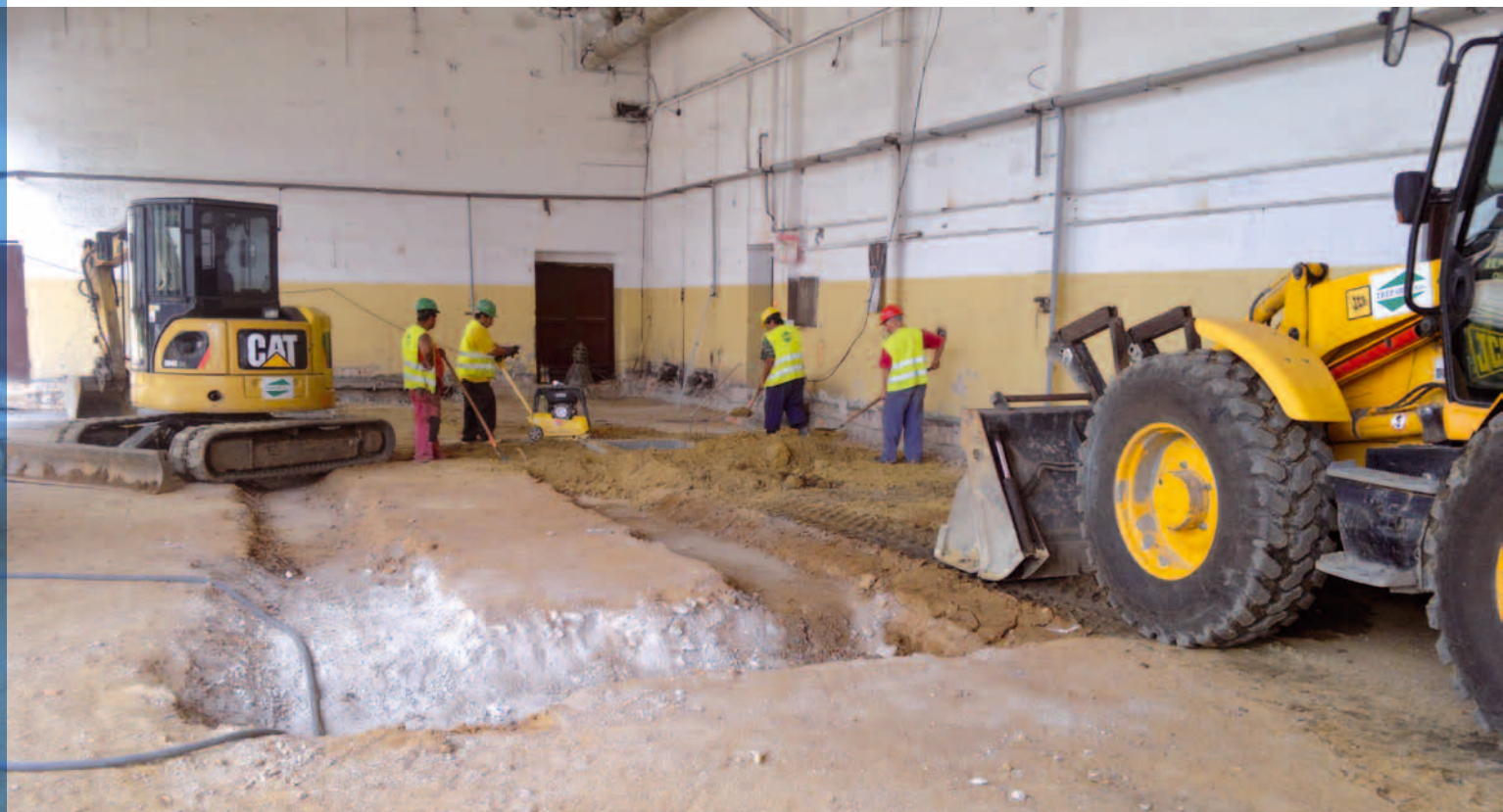
Původní hala prošla celkovou rekonstrukcí
