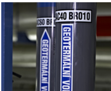
Pro výrobu tepla využívá TERMO geotermální vodu z hloubky 545 m
