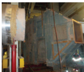
Demontáž ohříváku vzduchu (LUVO)
