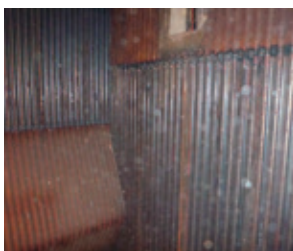
Vyměněná membránová stěna
