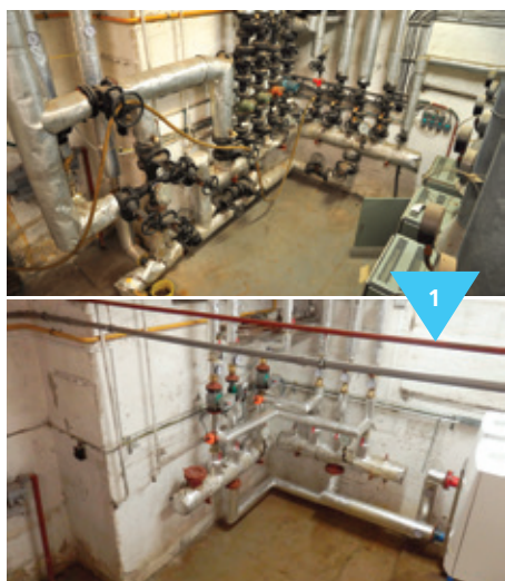
(1) Holice, Kulturní dům: rozdělovač a sběrač topné vody před a po realizaci v kotelně objektu (2) Holice, Kulturní dům: plynová kotelná před a po realizaci
