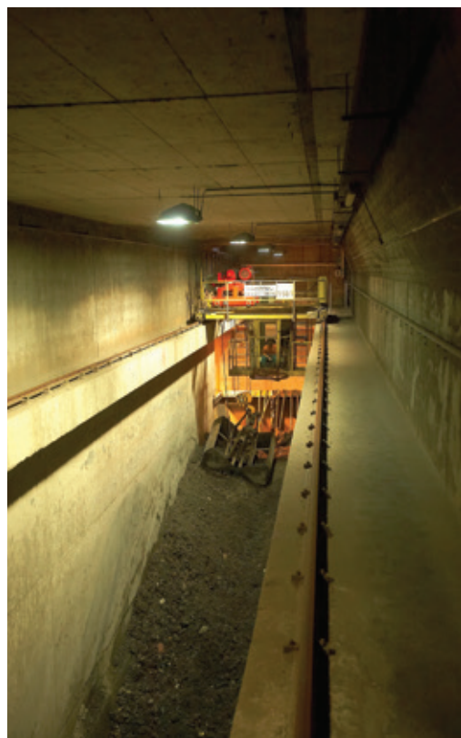
Bunkr strusky v TERMIZO – místo, kde končí popeloviny z využívání odpadů
