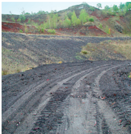
SPRUK: cesta uvnitř skládky
